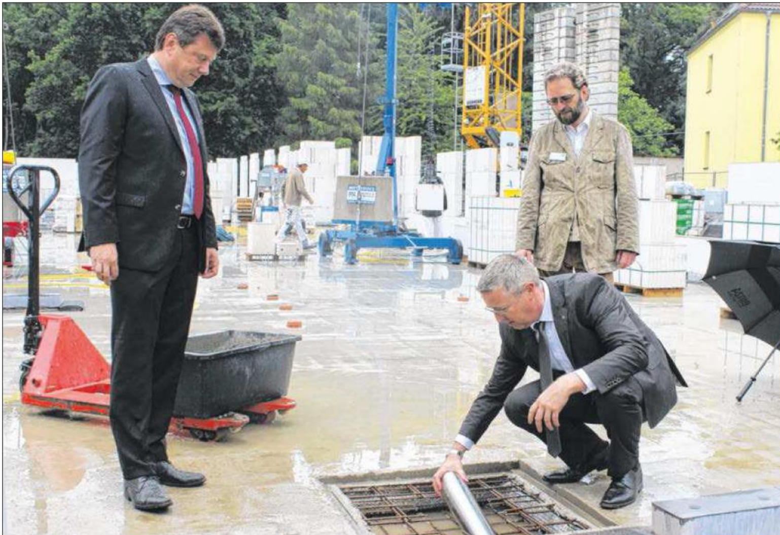
Unter den Augen von Michael Bartels (l.), Vorsteher des Pommerschen Diakonievereins, und von Regionalleiter Christian Schneider (r.) legt Jens Tode, Bereichsgeschäftsführer für den Bereich Assistieren, den Grundstein für den Neubau am Arndt-Heim in Bergen. Foto: Chris-Marco Herold
