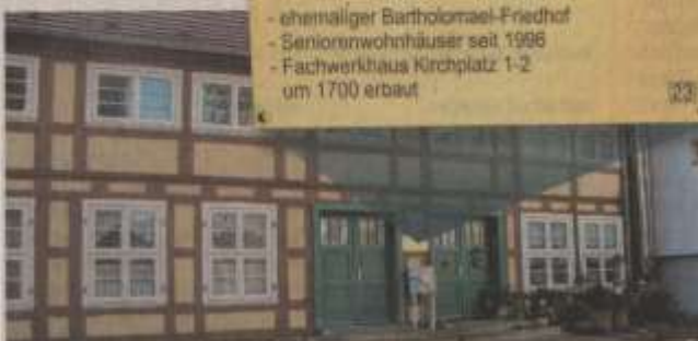
Dieses alte Fachwerkgebäude konnte als einziges Kirchplatzhaus noch erhalten und saniert werden. An ihm erinnert eine Tafel an die denkmalgeschützten Gebäude.
