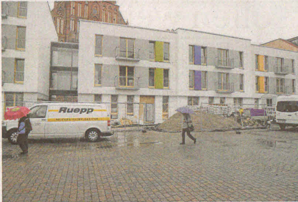
Seit Kurzem zeigt sich das künftige Seniorenhaus ohne Rüstung, dafür aber mit moderner Architektur und frischen Farben. Nicht jeder ist davon begeistert.
