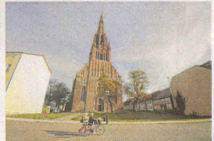
Der Baulücke mit dem freien Blick auf die Kirche trauern noch heute einige nach.
