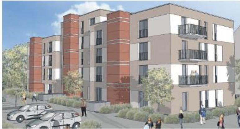
So sieht das Haus in der Planung aus. Bild: fmra – frank milenz rabenseifner architekten
